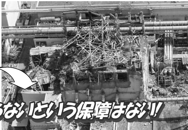
水素爆発で建屋が破壊された福島第一原発3号機
